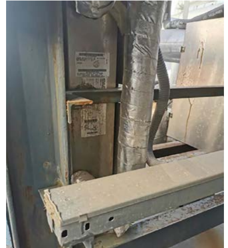
Uno dei modelli B80AS SWEP installati in loco.
