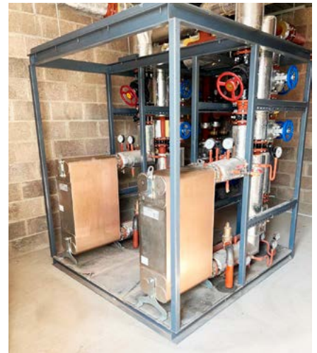
La soluzione per sottostazioni a prova di futuro, che utilizza gli scambiatori di calore a piastre saldobrasate B439Hx240 di SWEP.
