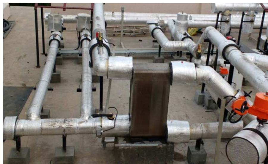
Installazione di uno scambiatore di calore SWEP B439.
