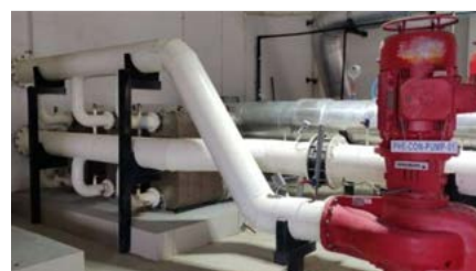
Installazione di uno scambiatore di calore SWEP B439.
