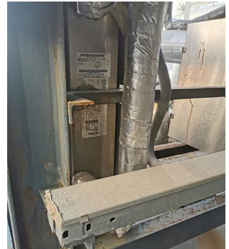
L'un des SWEP B80AS installés sur le site.
