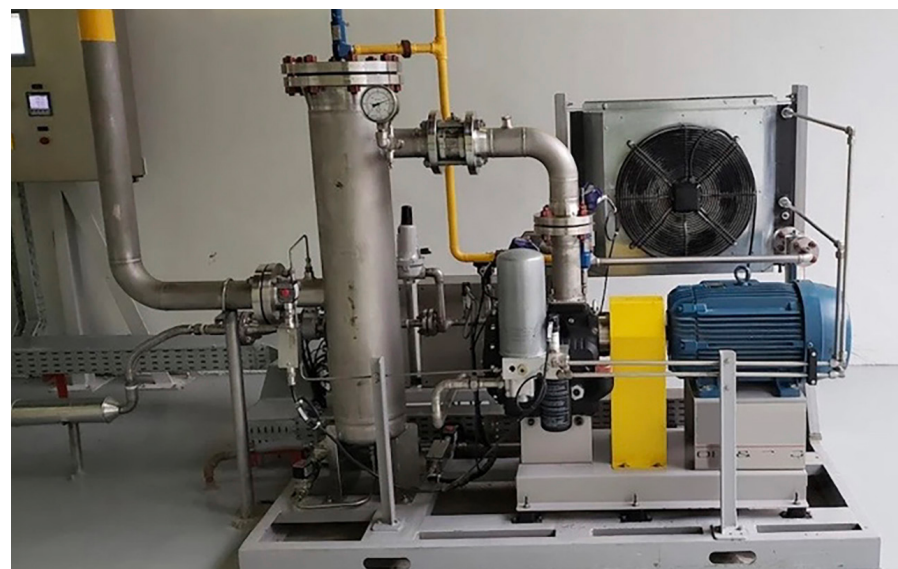
Système de biogaz équipé d'échangeurs thermiques à plaques brasées SWEP B10T.
