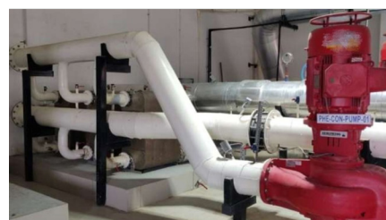
Installation d'un SWEP B439.
