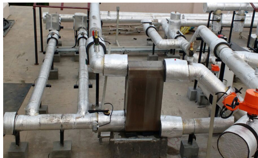
Installation d'un SWEP B439.
