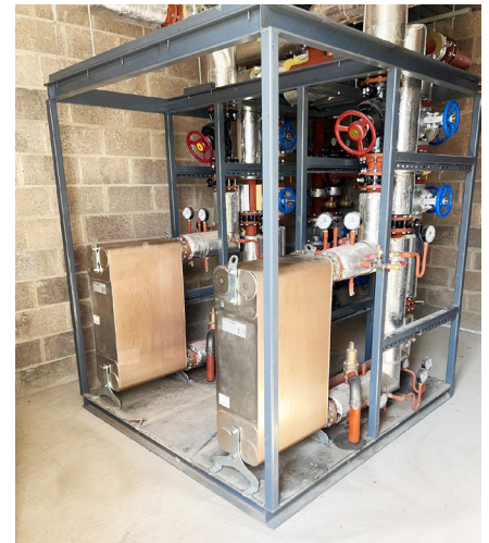
Die zukunftssichere Lösung für die Übergabestation, die mit gelöteten Plattenwärmetauschern des Typs B439Hx240 von SWEP ausgestattet ist.
